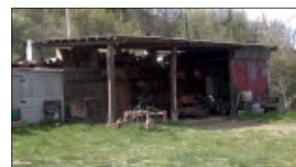
Manufatti precari utilizzati come legnaie, deposito materiali, ecc., il manto di copertura risulta non coerente al contesto ambientale; è precario l'assemblaggio strutturale
