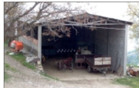
tipo 4N.1a con strutture verticali in c.a. parzialmente tamponato - scheda n. 728
