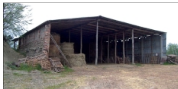
Manufatti precari utilizzati come fienili, il manto di copertura risulta non coerente al contesto ambientale; è precario l'assemblaggio strutturale
