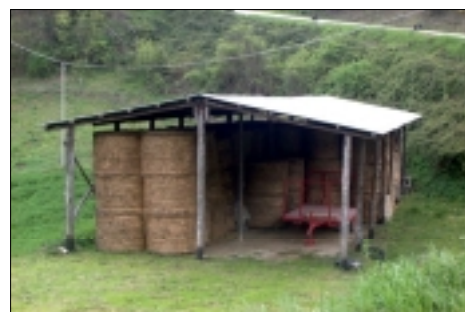
Manufatti precari utilizzati come fienili, il manto di copertura risulta non coerente al contesto ambientale; è precario l'assemblaggio strutturale
