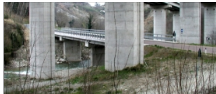
tipo 5N.2a ponte sul Savio sotto l'E45 - scheda n. 97
