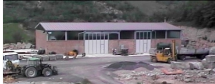
tipo 1.3Nb capannone con struttura prefabbricata - scheda n. 384
