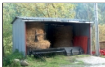
Manufatti precari utilizzati come deposito mezzi, risultano non coerenti al contesto per materiali utilizzati; è precario l'assemblaggio strutturale
