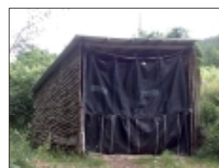
Manufatti precari utilizzati come legnaie, deposito materiali, ecc., il manto di copertura risulta non coerente al contesto ambientale; è precario l'assemblaggio strutturale
