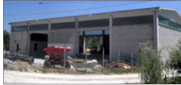
tipo 1.3Nb capannone con struttura prefabbricata- scheda n. 593
