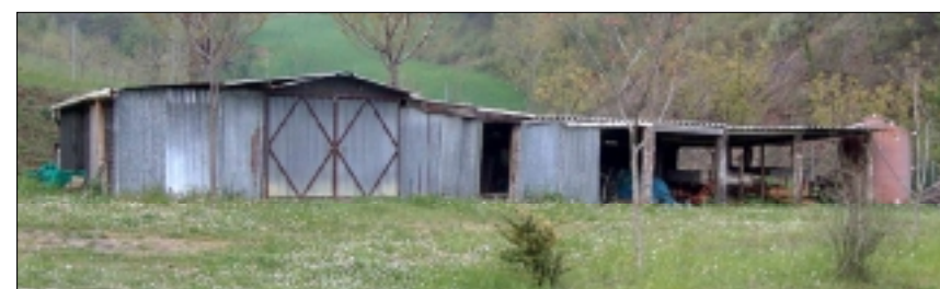
Baracche in materiale di recupero (lamiera, lastre ondulate, legno ecc.)
