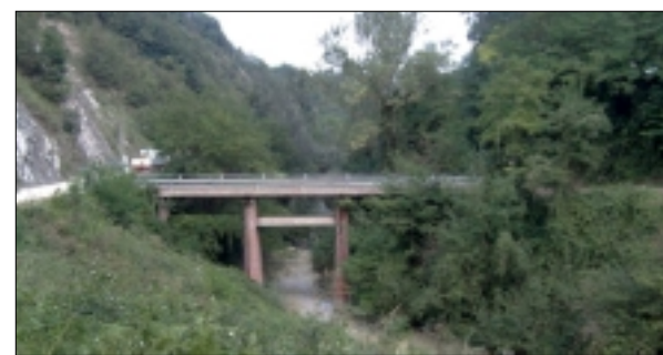
tipo 5N.2a ponte sul Borello - scheda n. 823
